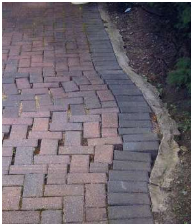
Insufficient edge restraint
